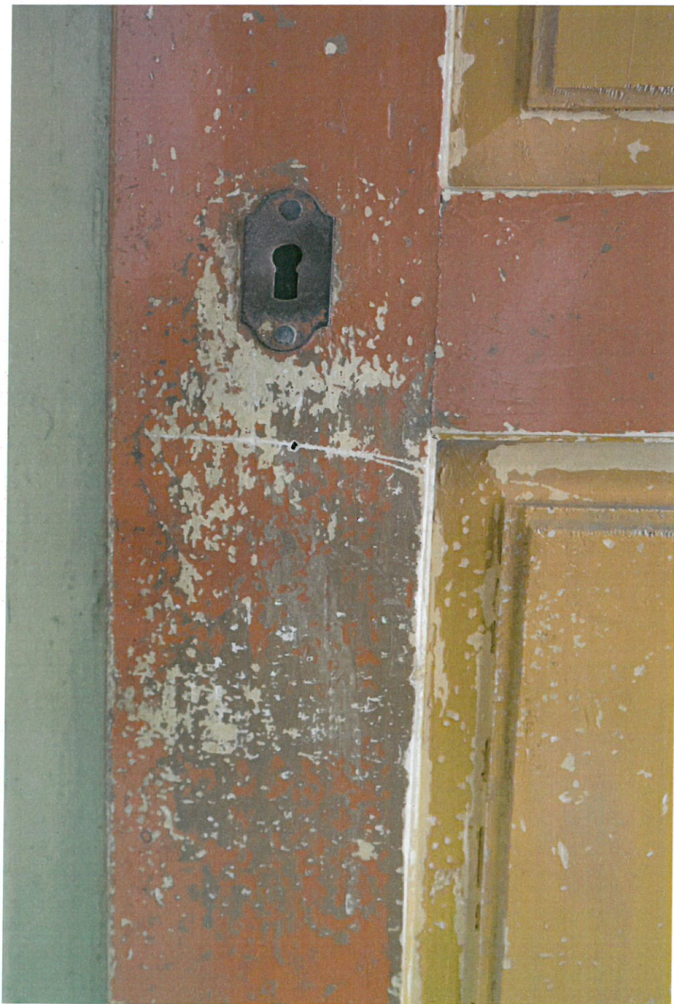
Fot. nr 27. Kościół pw Podwyższenia Krzyża Świętego w Starej Wsi. Drzwi dwuskrzydłowe do nawy kościoła i jednoskrzydłowe do składzika. Stan przed konserwacją. Zbliżenie na fragment z zamkiem. Widoczne uszkodzenia mechaniczne powierzchni, warstwy kolejnych przemalowań. data: czerwiec 2023r. autor: Katarzyna Gąsienica Sieczka
