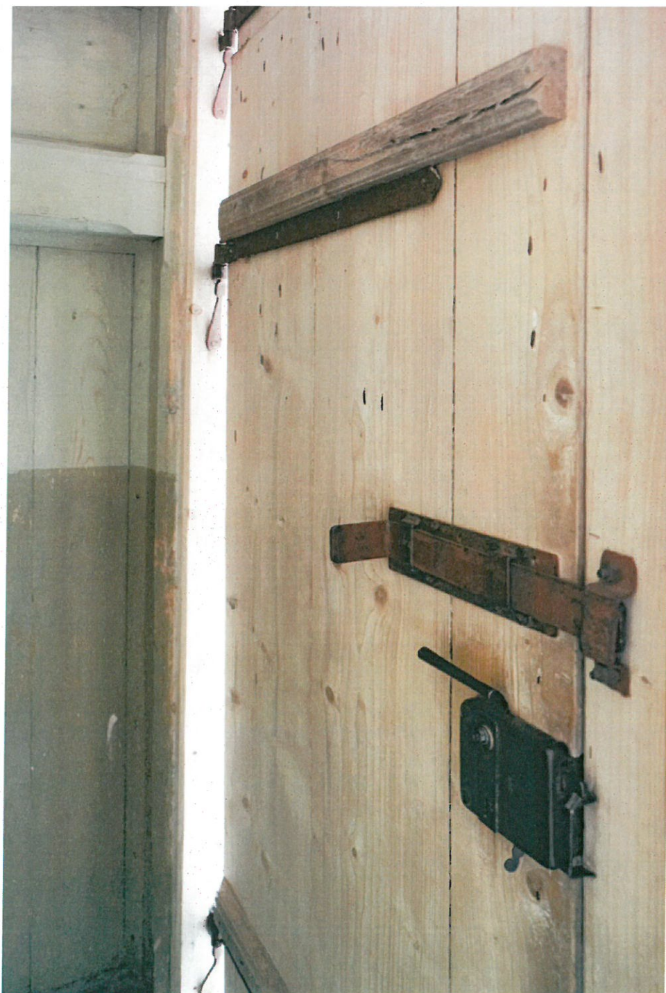
Fot. nr 42 Kościół pw Podwyższenia Krzyża Świętego w Starej Wsi. Przedsionek przy zachodnim wejściu do kościoła. Stan przed konserwacją. Prawe skrzydło drzwiowe. W dolnej części widoczne zamek i zasuw furtki. data: czerwiec 2023r.
