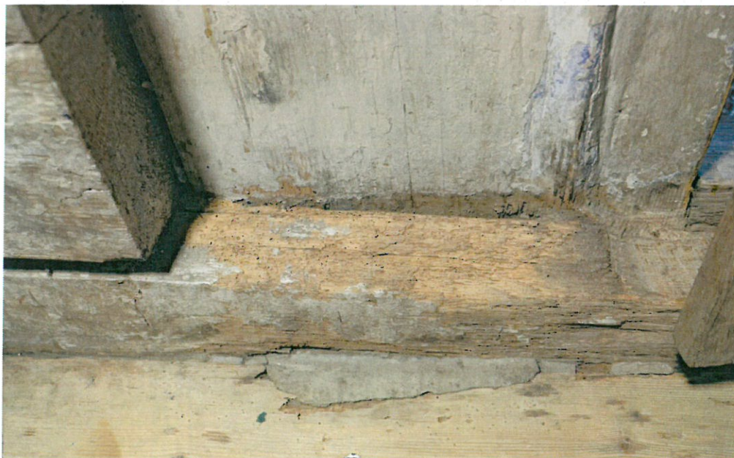
Fot. nr 19. Kościół pw Podwyższenia Krzyża Świętego w Starej Wsi. Wnętrze zakrystii. Stan przed konserwacją. Fragment belki podwalinowej po stronie południowej. Widoczne zniszczenie struktury drewna przez działanie drewnojadów. data: czerwiec 2023r. autor: Katarzyna Gąsienica Sieczka
