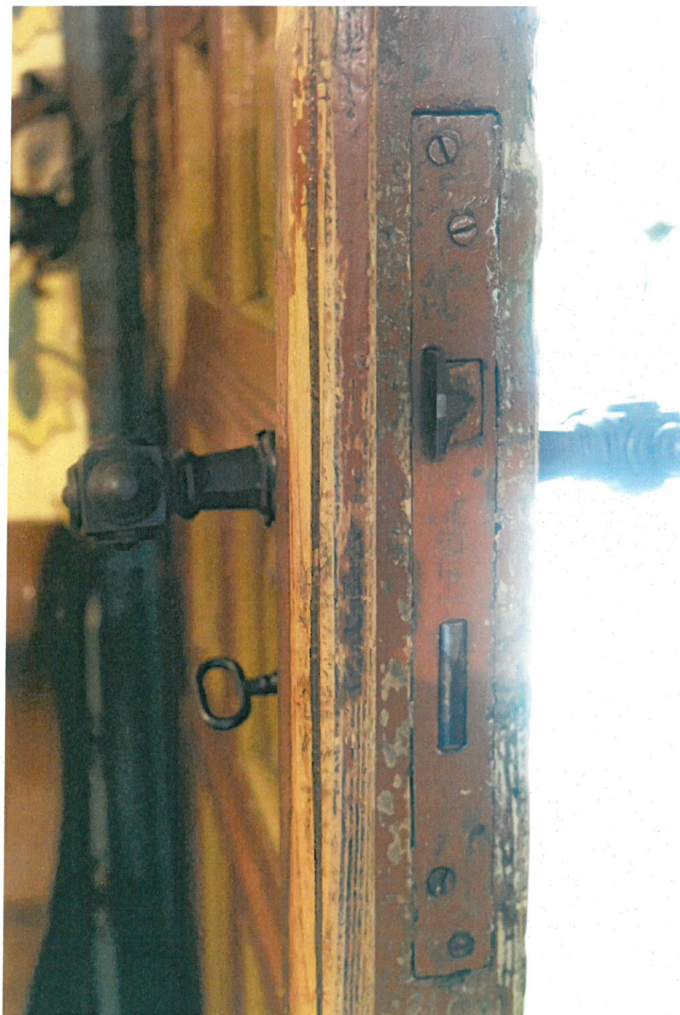
Fot. nr 25. Kościół pw Podwyższenia Krzyża Świętego w Starej Wsi. Dwuskrzydłowe drzwi pomiędzy nawą kościoła a przedsionkiem. Stan przed konserwacją. Zbliżenie na fragment z zamkiem. Widoczne uszkodzenia mechaniczne powierzchni, warstwy kolejnych przemalowań. data: czerwiec 2023r.
