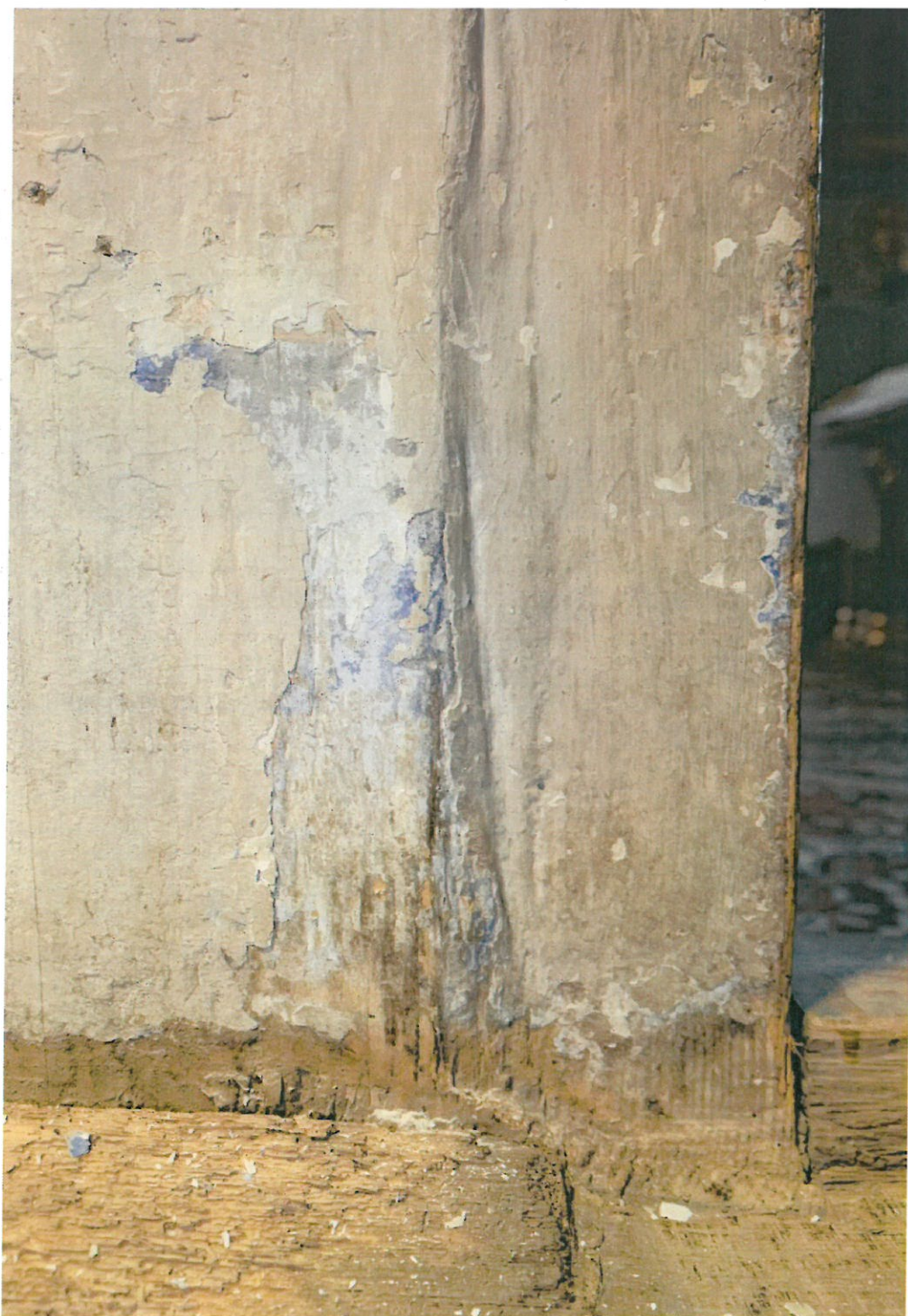
Fot. nr 10. Kościół pw Podwyższenia Krzyża Świętego w Starej Wsi. Wnętrze zakrystii. Stan przed konserwacją. Fragment ściany południowej. Widoczne nawarstwienia malarskie w kolorze ultramaryny.
