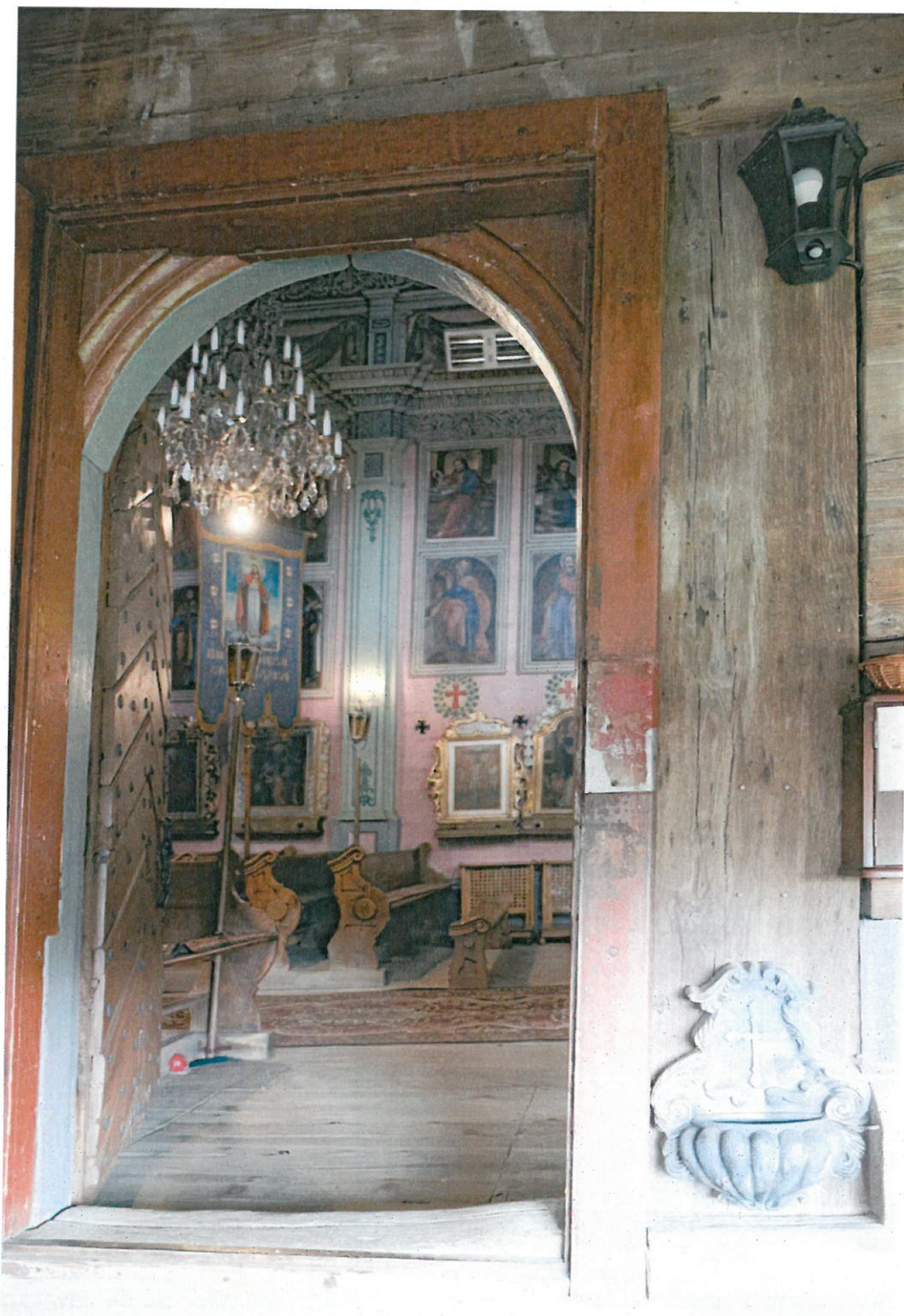
Fot. nr 45. Kościół pw Podwyższenia Krzyża Świętego w Starej Wsi. Wejście do nawy kościoła po stronie południowej. Stan przed konserwacją. Widok od strony zewnętrznej. Widoczna ościeżnica nowych, dodanych drzwi. data: czerwiec 2023r.
