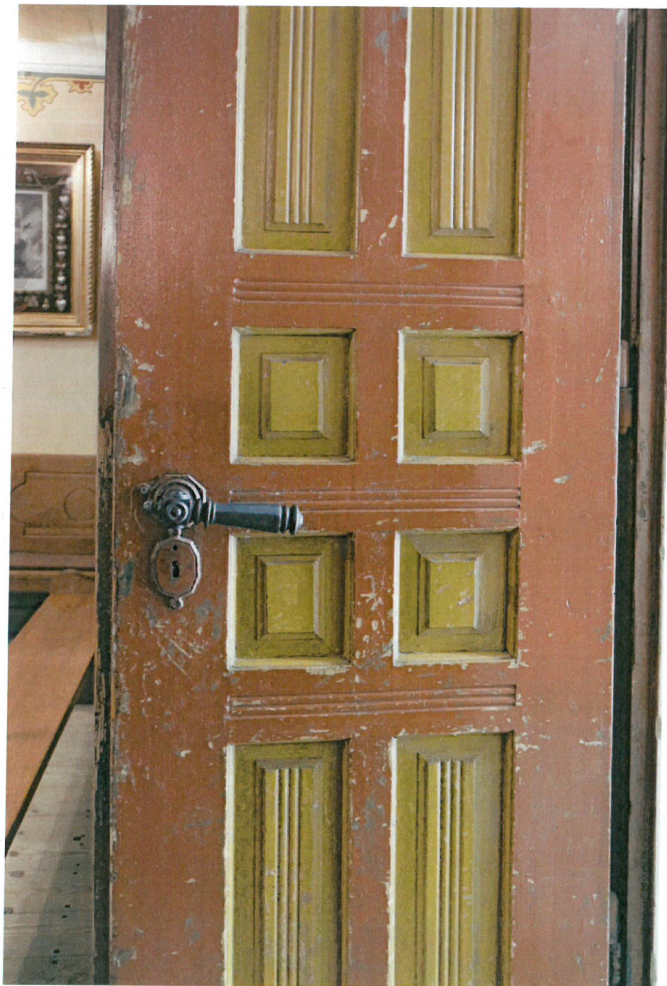
Fot. nr 22. Kościół pw Podwyższenia Krzyża Świętego w Starej Wsi. Dwuskrzydłowe drzwi pomiędzy nawą kościoła a przedsionkiem. Stan przed konserwacją. Widoczne uszkodzenia powierzchni drewna, wtórna powłoka malarska. data: czerwiec 2023r.
