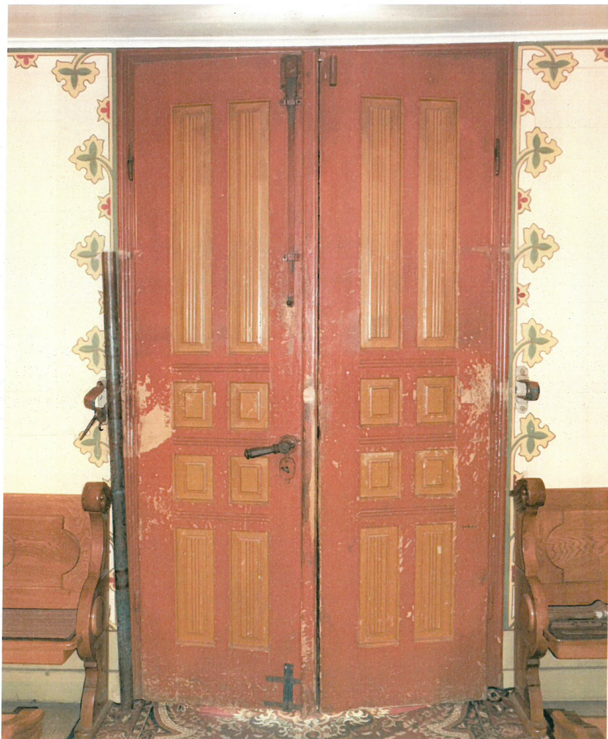
Fot. nr 21. Kościół pw Podwyższenia Krzyża Świętego w Starej Wsi. Dwuskrzydłowe drzwi pomiędzy nawą kościoła a przedsionkiem. Stan przed konserwacją. Widoczne uszkodzenia powierzchni drewna, wtórna powłoka malarska. data: czerwiec 2023r.
