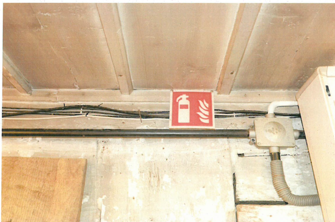
Fot. nr 12, 13. Kościół pw Podwyższenia Krzyża Świętego w Starej Wsi. Wnętrze zakrystii. Stan przed konserwacją. Sufit pomieszczenia zakrystii. Deskowanie z listwami na łączeniach. data: czerwiec 2023r. autor: Katarzyna Gąsienica Sieczka
