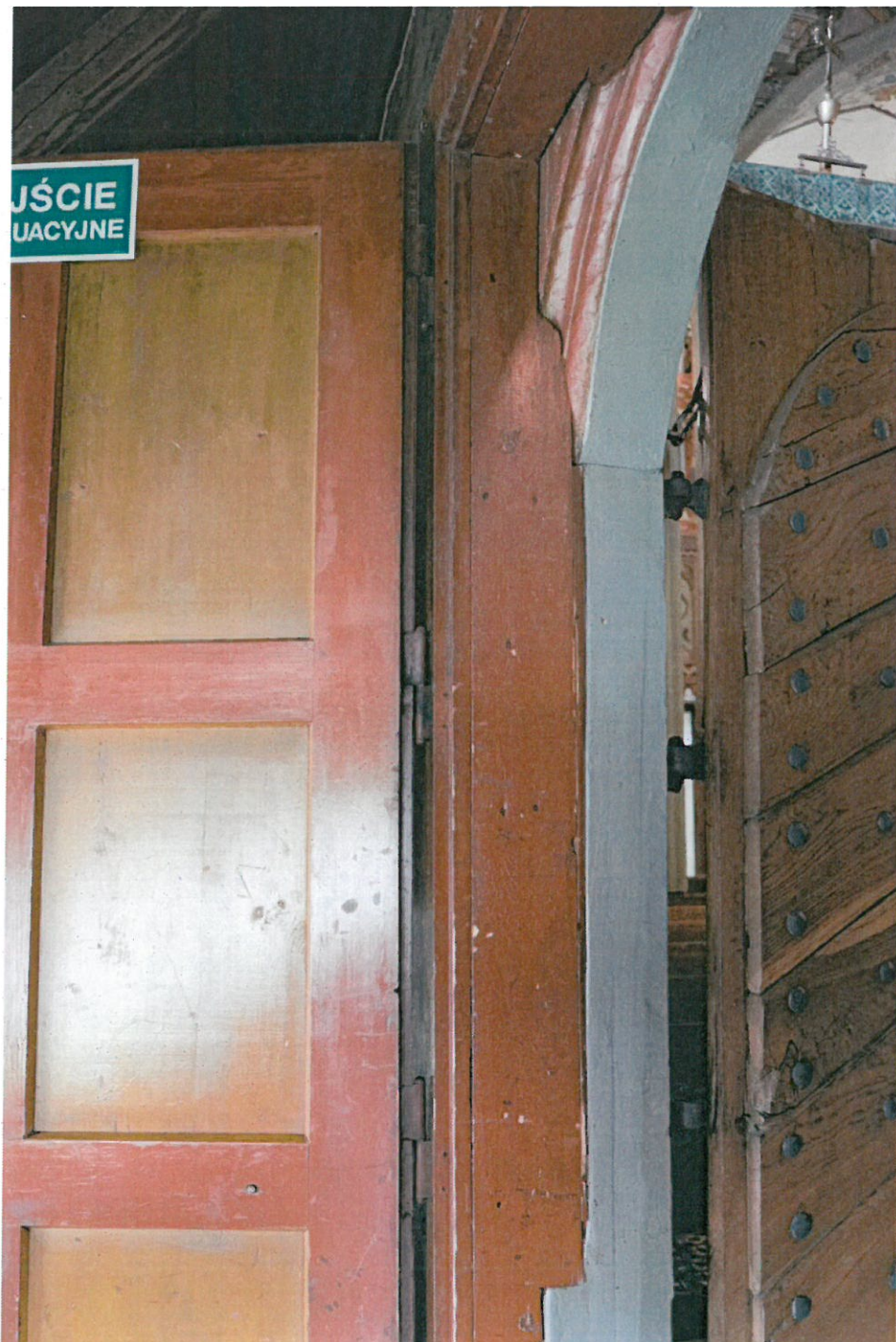
Fot. nr 49. Kościół pw Podwyższenia Krzyża Świętego w Starej Wsi. Wejście do nawy kościoła po stronie południowej. Stan przed konserwacją. Widok od strony zewnętrznej. Widoczny sposób docięcia współczesnej ościeżnicy do zabytkowego portalu. data: czerwiec 2023r.
