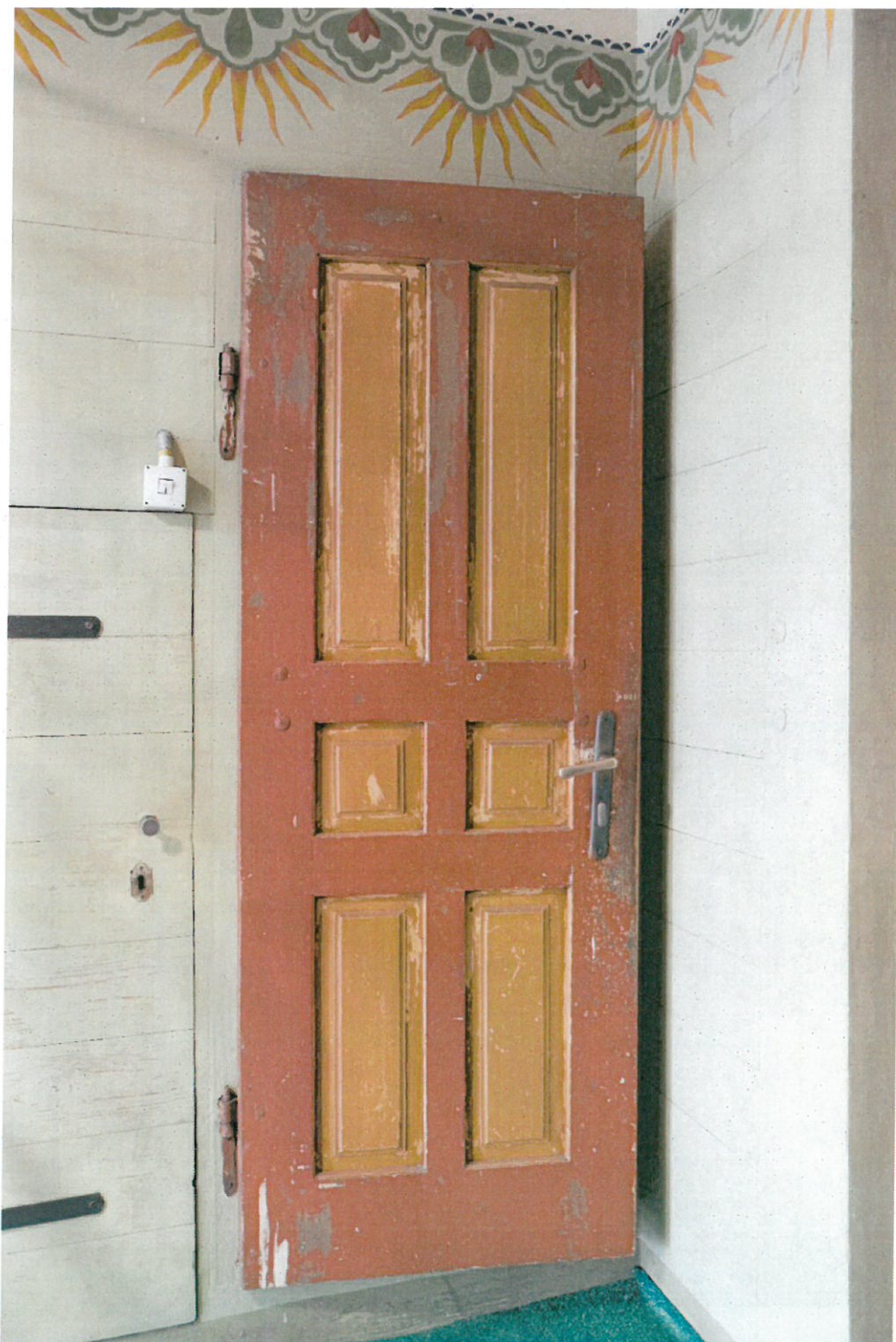
Fot. nr 29. Kościół pw Podwyższenia Krzyża Świętego w Starej Wsi. Jednoskrzydłowe drzwi prowadzące na chór. Stan przed konserwacją. Widoczne uszkodzenia mechaniczne powierzchni, warstwy kolejnych przemalowań. data: czerwiec 2023r.
