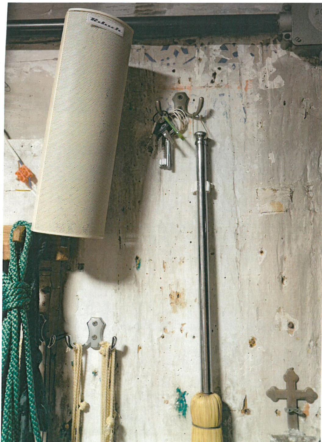
Fot. nr 7. Kościół pw Podwyższenia Krzyża Świętego w Starej Wsi. Wnętrze zakrystii. Stan przed konserwacją. Fragment ściany południowej. Widoczne nawarstwienia malarskie, uszkodzenia powierzchni drewna, otwory wylotowe świadczące o działalności drewnojadów. data: czerwiec 2023r. autor: Katarzyna Gąsienica Sieczka
