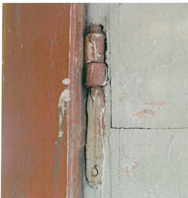
Fot. nr 32 Kościół pw Podwyższenia Krzyża Świętego w Starej Wsi. Jednoskrzydłowe drzwi prowadzące na chór. Stan przed konserwacją. Widoczny jeden z zawiasów, na których osadzone jest skrzydło. data: czerwiec 2023r. autor: Katarzyna Gąsienica Sieczka
