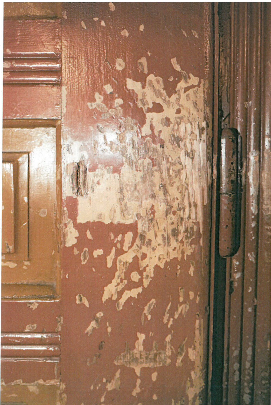
Fot. nr 23. Kościół pw Podwyższenia Krzyża Świętego w Starej Wsi. Dwuskrzydłowe drzwi pomiędzy nawą kościoła a przedsionkiem. Stan przed konserwacją. Fragment jednego ze skrzydeł. Widoczne uszkodzenia mechaniczne powierzchni, warstwy kolejnych przemalowań. data: czerwiec 2023r. autor: Katarzyna Gąsienica Sieczka
