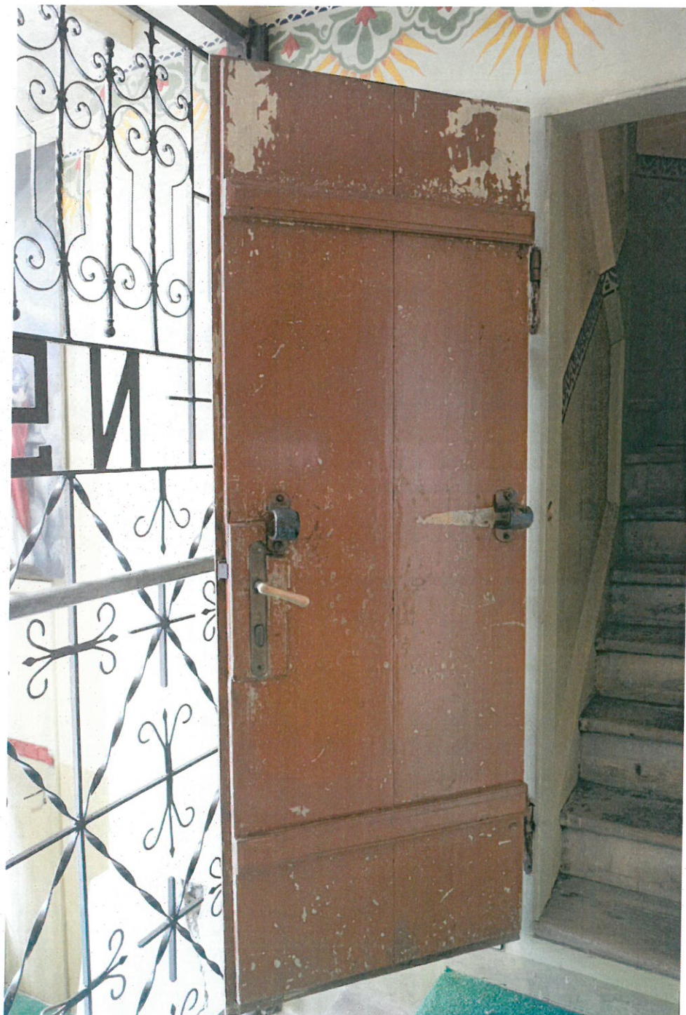
Fot. nr 30. Kościół pw Podwyższenia Krzyża Świętego w Starej Wsi. Jednoskrzydłowe drzwi prowadzące na chór. Stan przed konserwacją. Widoczne uszkodzenia mechaniczne powierzchni, warstwy kolejnych przemalowań. data: czerwiec 2023r.
