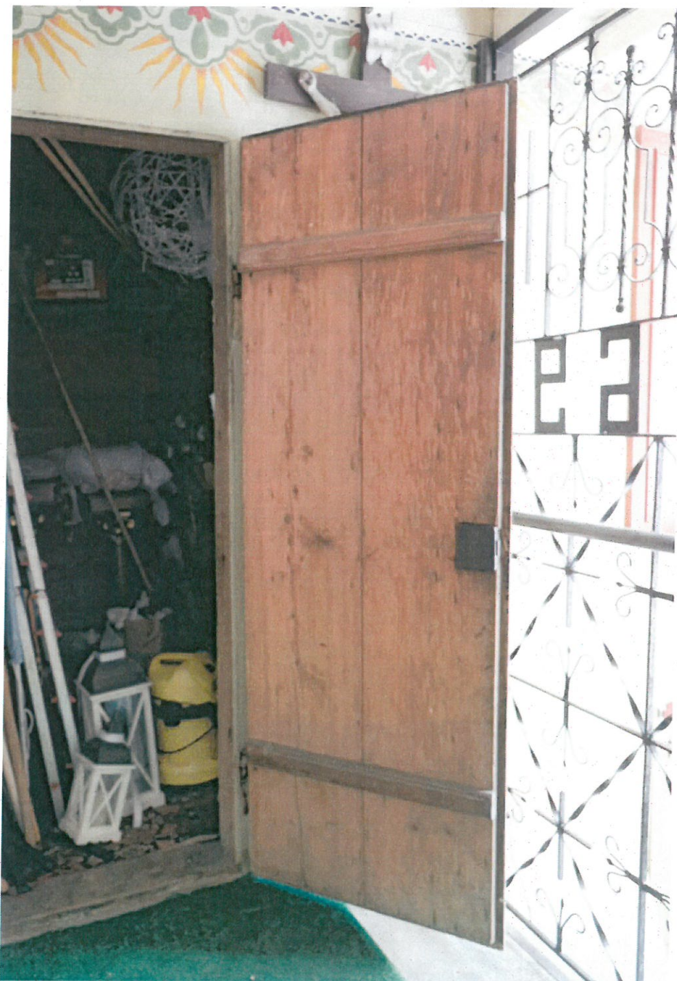
Fot. nr 28. Kościół pw Podwyższenia Krzyża Świętego w Starej Wsi. Drzwi jednoskrzydłowe do składzika. Stan przed konserwacją. Widoczne oczyszczona powierzchnia od strony wewnętrznej, szprosy wzmacniające konstrukcję. data: czerwiec 2023r.
