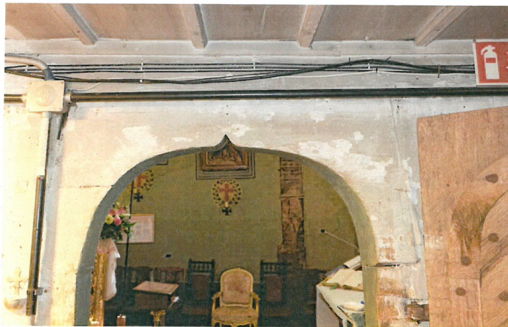
Fot. nr 16. Kościół pw Podwyższenia Krzyża Świętego w Starej Wsi. Wnętrze zakrystii. Stan przed konserwacją. Drzwi w ścianie południowej, prowadzące do prezbiterium, Zwieńczenie portalu w kształcie oślego grzbietu.
