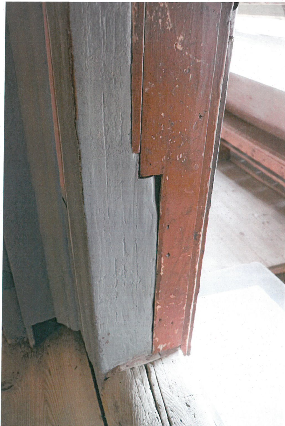
Fot. nr 50. Kościół pw Podwyższenia Krzyża Świętego w Starej Wsi. Wejście do nawy kościoła po stronie południowej. Stan przed konserwacją. Widok od strony zewnętrznej. Widoczny sposób docięcia współczesnej ościeżnicy do zabytkowego portalu. data: czerwiec 2023r.
