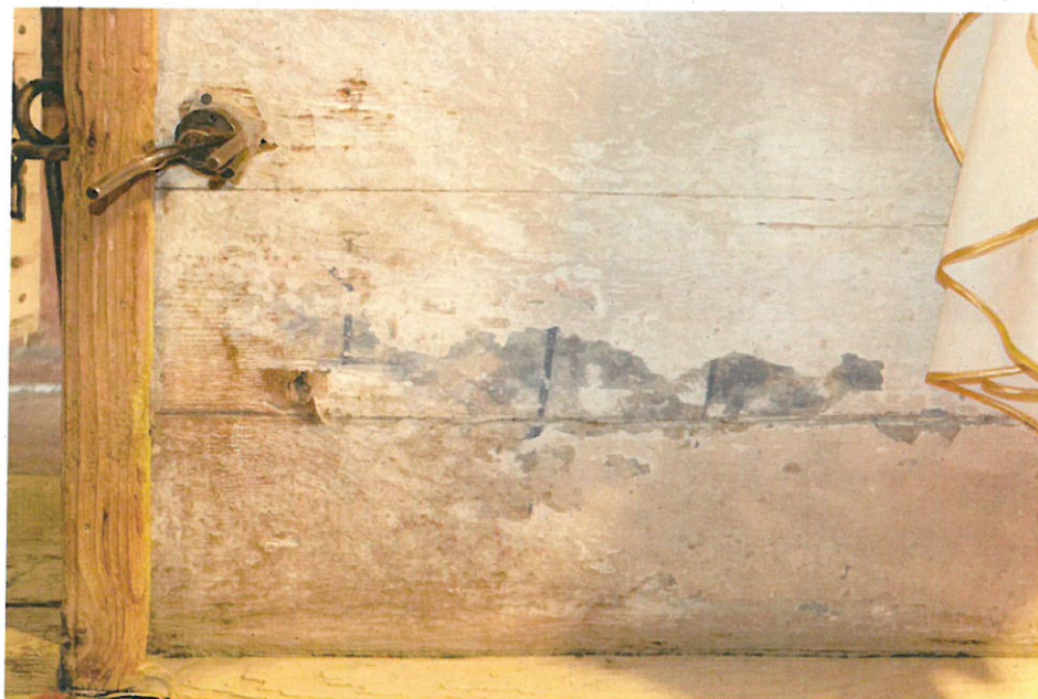
Fot. nr 9. Kościół pw Podwyższenia Krzyża Świętego w Starej Wsi. Wnętrze zakrystii. Stan przed konserwacją. Fragment ściany południowej. Widoczne nawarstwienia malarskie na powierzchni belki podwalinowej. W ubytkach widoczne fragmenty dekoracji malarskiej- ornament w kolorze ultramaryny.
