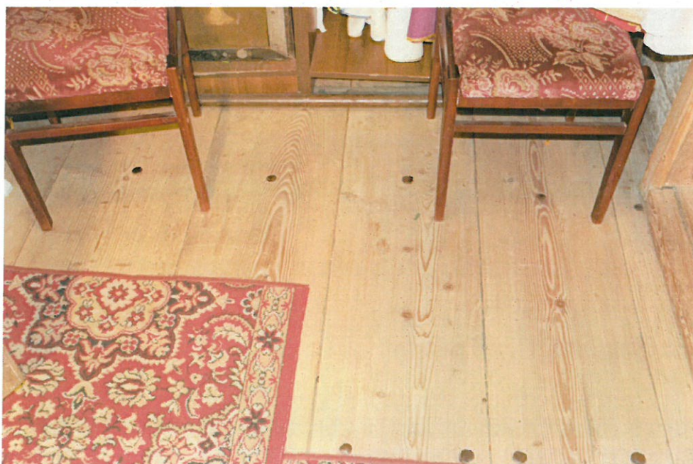
Fot. nr 3. Kościół pw Podwyższenia Krzyża Świętego w Starej Wsi. Wnętrze zakrystii. Stan przed konserwacją. Podłoga z desek przybitych kutymi gwoździami. data: czerwiec 2023r. autor: Katarzyna Gąsienica Sieczka
