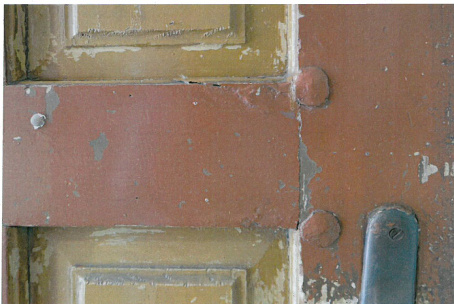
Fot. nr 31. Kościół pw Podwyższenia Krzyża Świętego w Starej Wsi. Jednoskrzydłowe drzwi prowadzące na chór. Stan przed konserwacją. Widoczne uszkodzenia mechaniczne powierzchni, warstwy kolejnych przemalowań, głowy kutych gwoździ wzmacniających konstrukcję skrzydła. data: czerwiec 2023r. autor: Katarzyna Gąsienica Sieczka
