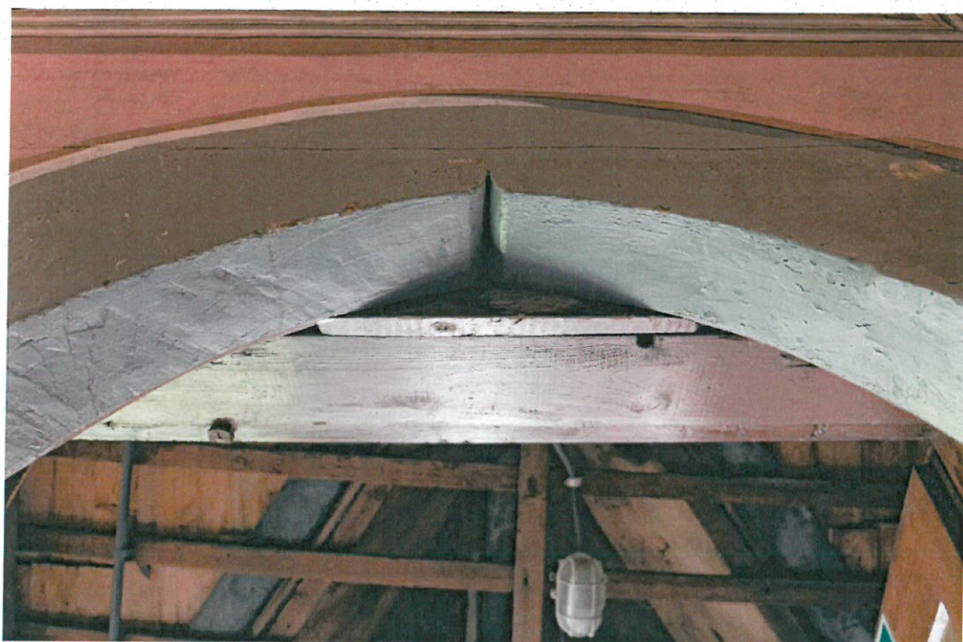
Fot. nr 47, 48. Kościół pw Podwyższenia Krzyża Świętego w Starej Wsi. Wejście do nawy kościoła po stronie południowej. Stan przed konserwacją. Widoczny sposób docięcia współczesnej ościeżnicy do zabytkowego portalu. data: czerwiec 2023r.
