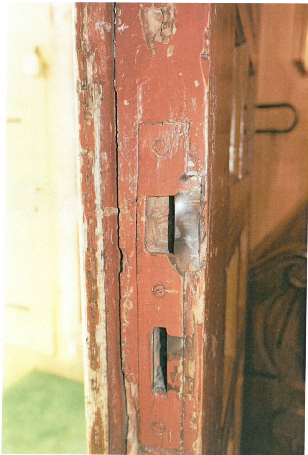
Fot. nr 24 Kościół pw Podwyższenia Krzyża Świętego w Starej Wsi. Dwuskrzydłowe drzwi pomiędzy nawą kościoła a przedsionkiem. Stan przed konserwacją. Zbliżenie na fragmentu. Widoczne uszkodzenia mechaniczne powierzchni, warstwy kolejnych przemalowań. data: czerwiec 2023r. autor: Katarzyna Gąsienica Sieczka
