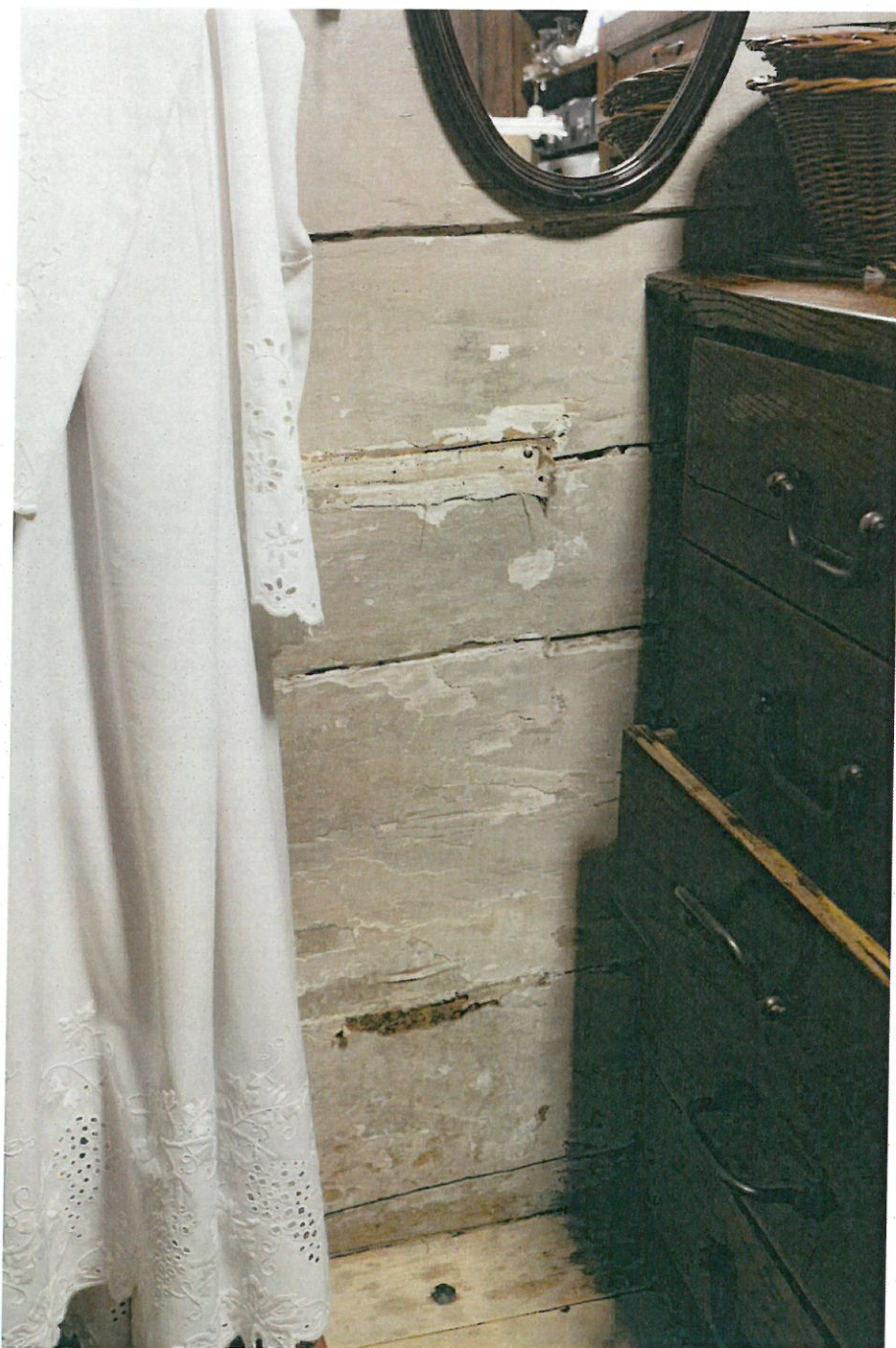
Fot. nr 11. Kościół pw Podwyższenia Krzyża Świętego w Starej Wsi. Wnętrze zakrystii. Stan przed konserwacją. Fragment ściany północnej. Widoczne pasy płótna wklejone w miejscach łączenia belek konstrukcyjnych ściany. Pasy wklejone były w różnych okresach historycznych. W trakcie planowanych prac konserwatorskich należy rozpoznać, czy było to również działanie pierwotne, w pierwszej warstwie historycznej. data: czerwiec 2023r.
